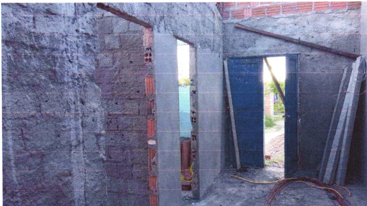
Foto 03 - CHAPISCO APLICADO EM ALVENARIA (COM PRESENÇA DE VÃOS) E ESTRUTURAS DE CONCRETO DE FACHADA, COM EQUIPAMENTO DE PROJEÇÃO. ARGAMASSA TRAÇO 1:3 COM PREPARO EM BETONEIRA 400 L. AF_06/2014
