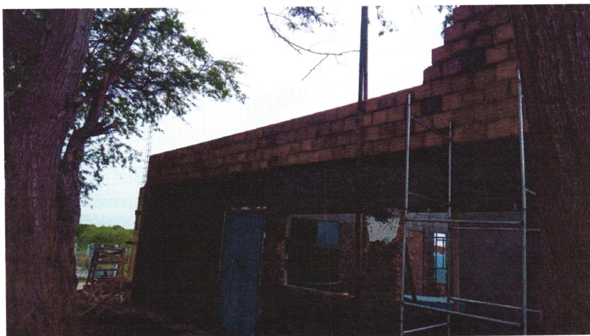
Foto 02 – ALVENARIA DE VEDAÇÃO DE BLOCOS CERÂMICOS FURADOS NA HORIZONTAL DE 9X19X29 CM (ESPESSURA 9 CM) E ARGAMASSA DE ASSENTAMENTO COM PREPARO EM BETONEIRA. AF_12/2021
