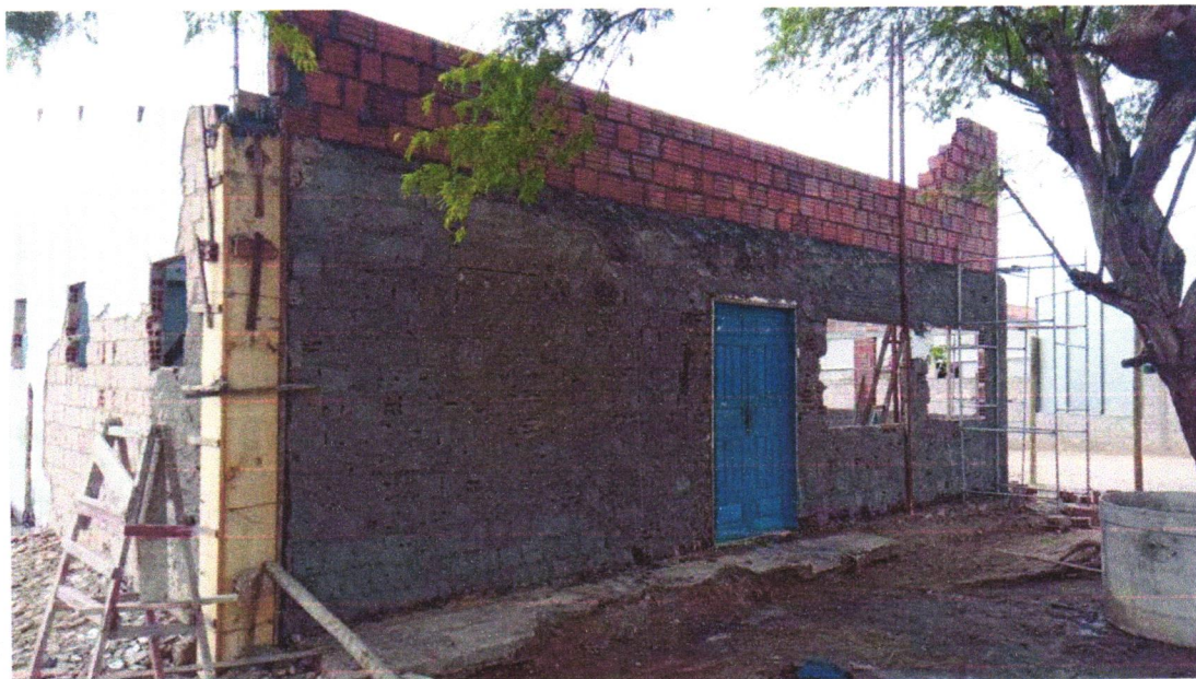
Foto 01 - ALVENARIA DE VEDAÇÃO DE BLOCOS CERÂMICOS FURADOS NA HORIZONTAL DE 9X19X29 CM (ESPESSURA 9 CM) E ARGAMASSA DE ASSENTAMENTO COM PREPARO EM BETONEIRA. AF_12/2021
