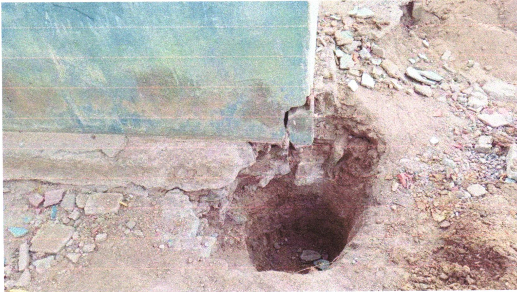
Foto 11 - Escavação manual para bloco de coroamento ou sapata (sem escavação para colocação de fôrmas). af_06/2017
