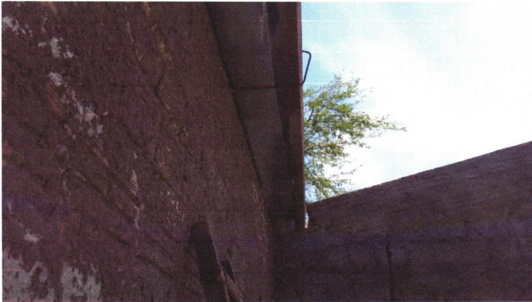
Foto 05- CALHA EM CHAPA DE AÇO GALVANIZADO NÚMERO 24, DESENVOLVIMENTO DE 33 CM, INCLUSO TRANSPORTE VERTICAL. AF_07/2019
