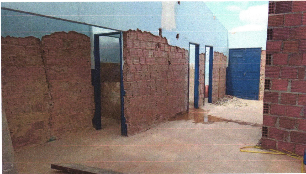
Foto 07 - Remoção de portas, de forma manual, sem reaproveitamento. af_12/2017
