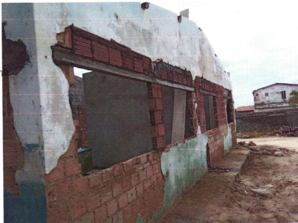
Foto 08 - VERGA PRÉ-MOLDADA PARA JANELAS COM ATÉ 1,5 M DE VÃO. AF_03/2016
