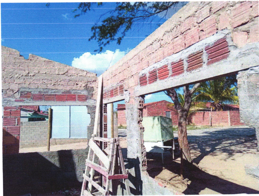
Foto 09 - VERGA PRÉ-MOLDADA PARA PORTAS COM ATÉ 1,5 M DE VÃO. AF_03/2016
