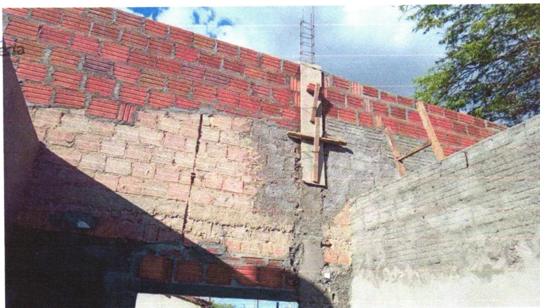
Foto 14 - (COMPOSIÇÃO REPRESENTATIVA) EXECUÇÃO DE ESTRUTURAS DE CONCRETO ARMADO, PARA EDIFICAÇÃO HABITACIONAL UNIFAMILIAR TÉRREA (CASA EM EMPREENDIMENTOS), FCK = 25 MPA. AF_01/2017
