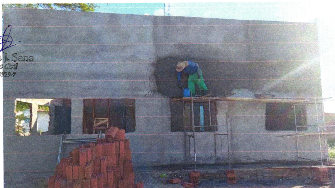
Foto 04 – MASSA ÚNICA, PARA RECEBIMENTO DE PINTURA OU CERÂMICA, ARGAMASSA INDUSTRIALIZADA, PREPARO MECÂNICO, APLICADO COM EQUIPAMENTO DE MISTURA E PROJEÇÃO DE 1,5 M3/H EM FACES INTERNAS DE PAREDES, ESPESSURA DE 5MM, SEM EXECUÇÃO DE TALISCAS. AF_06/2014
