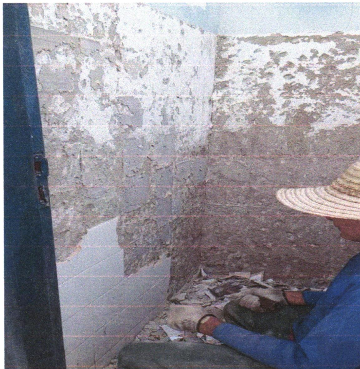
Foto 06 - Demolição de revestimento cerâmico ou azulejo
