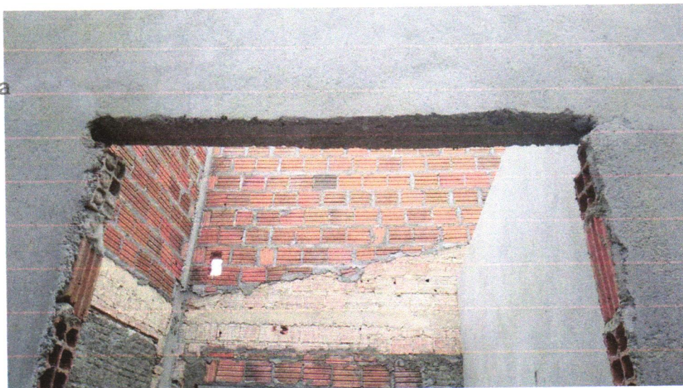
Foto 10 - VERGA PRÉ-MOLDADA PARA PORTAS COM ATÉ 1,5 M DE VÃO. AF_03/2016
